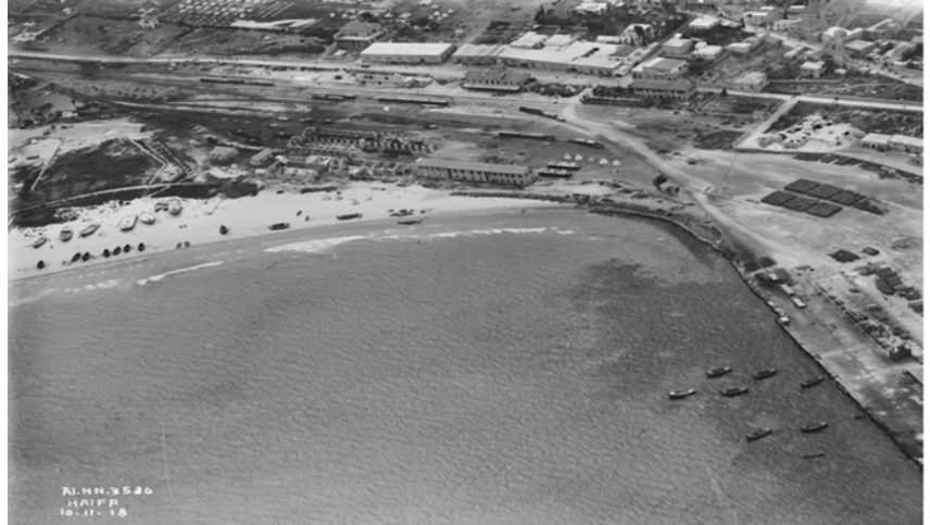
4. אזור החוף ותחנת הרכבת בתצלום אוויר שאינו אנכי B03540, שצילמה הטייסת האוסטרלית הראשונה במלחמת העולם הראשונה ביום 10.11.1918 [אתר האינטרנט של מוזיאון המלחמה בקנברה, אוסטרליה; זמין להעתקה בהפרדה בינונית]
