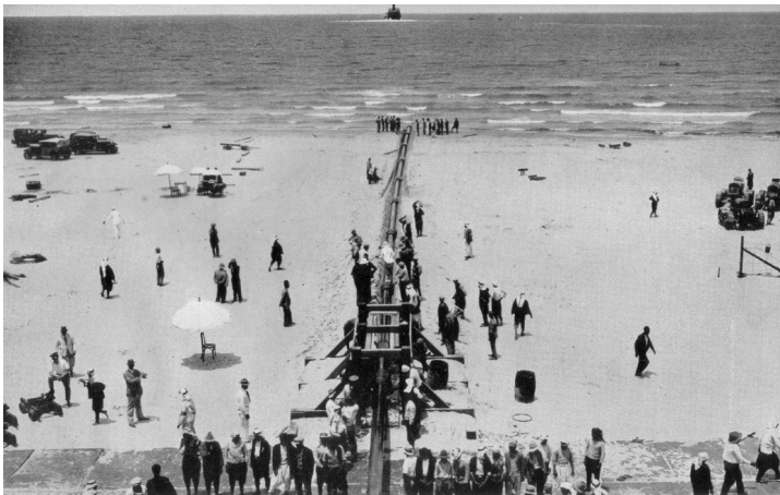
הכנסת הצינור למימי מפרץ חיפה 1930
